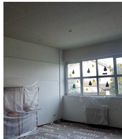
«L'IMPIEGO di controsoffitti certificati elimina i rischi legati al fenomeno dello sfondellamento (l'eventuale distacco di parti di intonaco dai soffitti, n.d.r.), contempla caratteristiche di antisismicità e permette di ottenere un altro importante risultato: la correzione acustica degli ambienti», spiega l'Assessore ai Lavori Pubblici Luca Bonizzi, secondo il quale grazie all'installazione di questi nuovi pannelli «vengono mitigati l'eccesso di riverberazione e la presenza di rumore di fondo».
