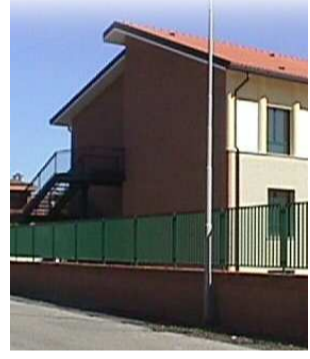
Una veduta esterna del fabbricato che dovrà essere, in parte, ristrutturato.
