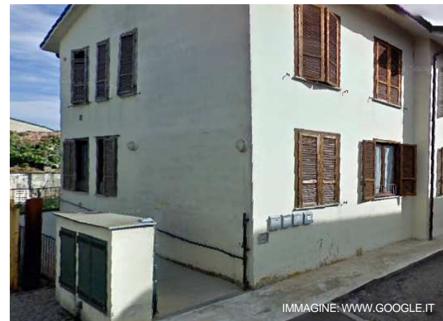
Il fabbricato in via Magnaghi, di proprietà comunale, dove al piano terra è presente l'appartamento che sarà messo a disposizione per un periodo determinato a 4 nuclei famigliari.
