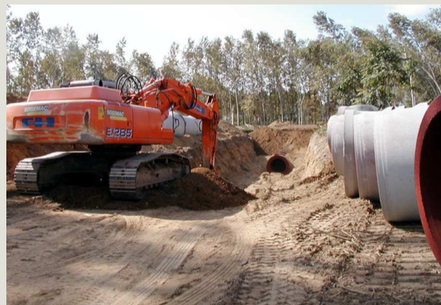
Una foto d'archivio illustra la costruzione della tratta del collettore che si è unita alla vasca volano in viale De Gasperi.
