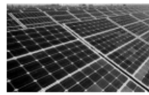
pannelli solari fotovoltaici
