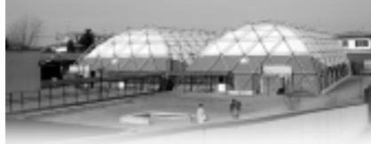
Sopra, le tensostrutture che verranno sostituite con altre in PVC autoestinguente, termo-riscaldato ed autopulente. Sotto, la piscina comunale poco distante.
