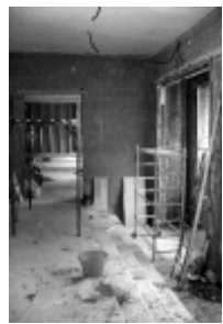
Il nuovo ingresso centrale.
