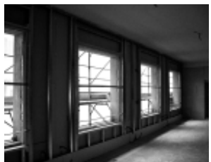
I muri rivolti all'esterno sono stati completamente rivestiti di un "cappotto" speciale.
