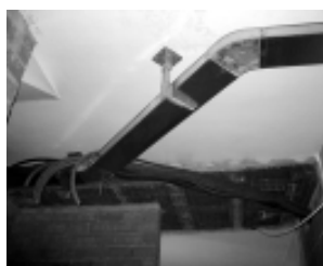
Tutti gli impianti (elettrico, idrico, riscaldamento e condizionamento) sono stati completamente rifatti e messi a norma secondo le più rigide misure di sicurezza.
