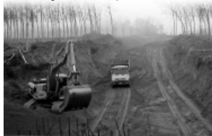
Depuratore: effettuate le carotazioni nel terreno della discarica abusiva
