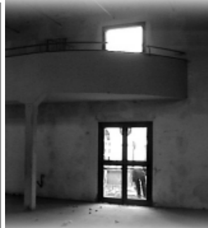
Una immagine del Centro Civico di Motta Visconti; in alto la ex bocciafila come si presenta oggi.
