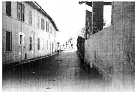
Alcune immagini che descrivono le operazioni di asfaltatura: sopra il titolo una fotografia di via Capo di Vico, mentre qui in alto è raffigurata via Palazzo. A destra in alto, alcuni degli interventi condotti presso il Centro Sportivo comunale.
