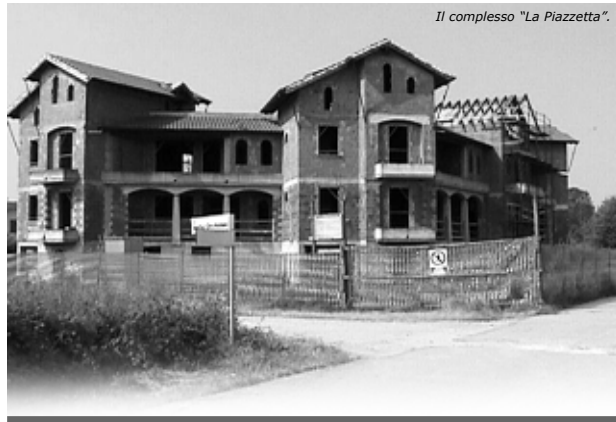
Il complesso "La Piazzetta".
